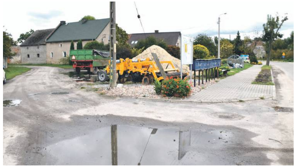
Fragment drogi gminnej od zakrętu do wjazdu trzeba będzie przesunąć
