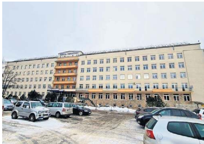
Zakopane, Szpital Powiatowy. Trwa reorganizacja, której efekt poprawi warunki leczenia
