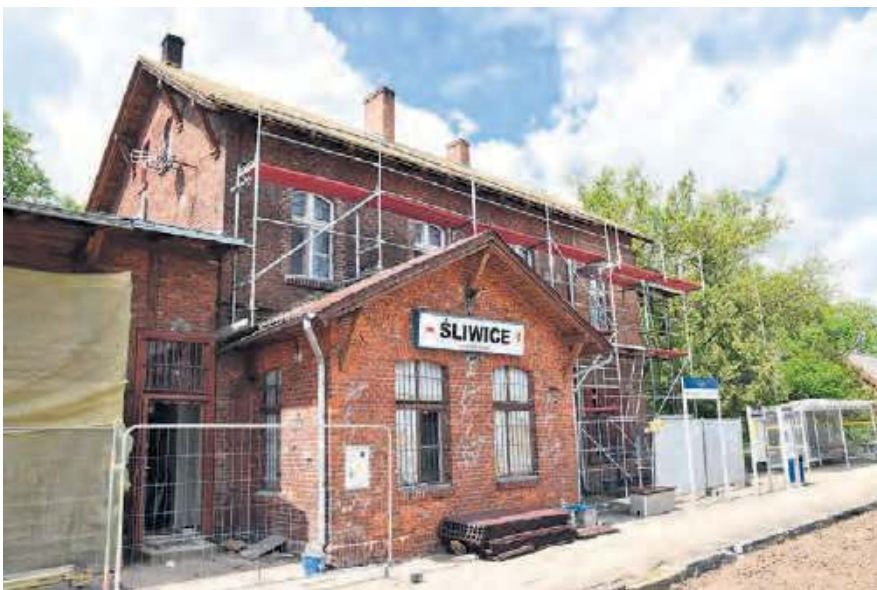
Budynek dworca ma bogatą historię. Jest zabytkiem i jego charakter ma zostać zachowany.
