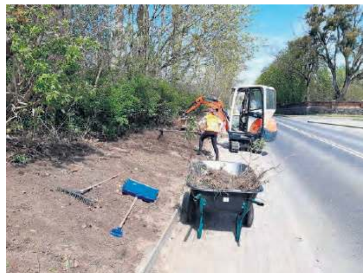
Prace porządkowe i przygotowawcze. Zaraz po nich będą nasadzenia.
