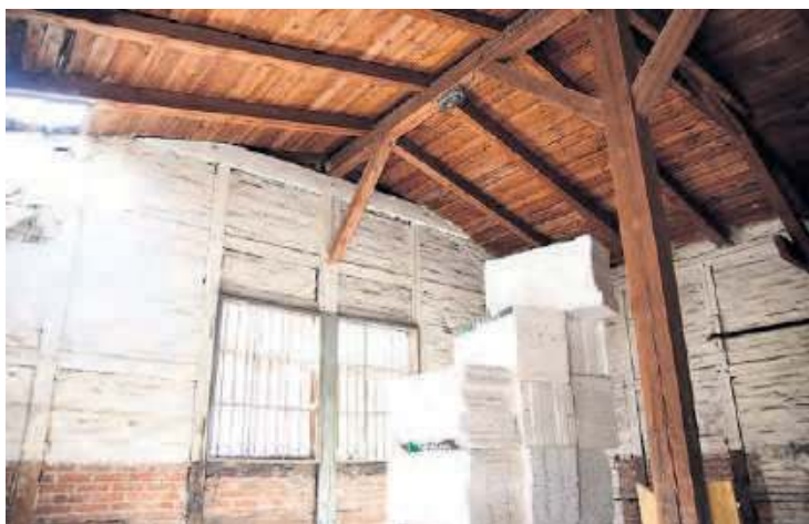
W budynku dworca w Śliwicach trwają prace budowlane.
