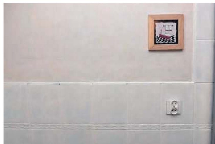
Płytki łazienkowe przemalowane specjalistyczną farbą.
