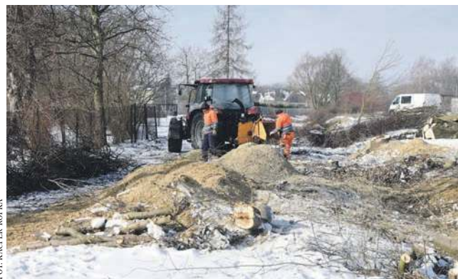
Rozpoczęły się prace w ramach modernizacji Kościelnej na os. Nowy Świat w Krzeszowicach
