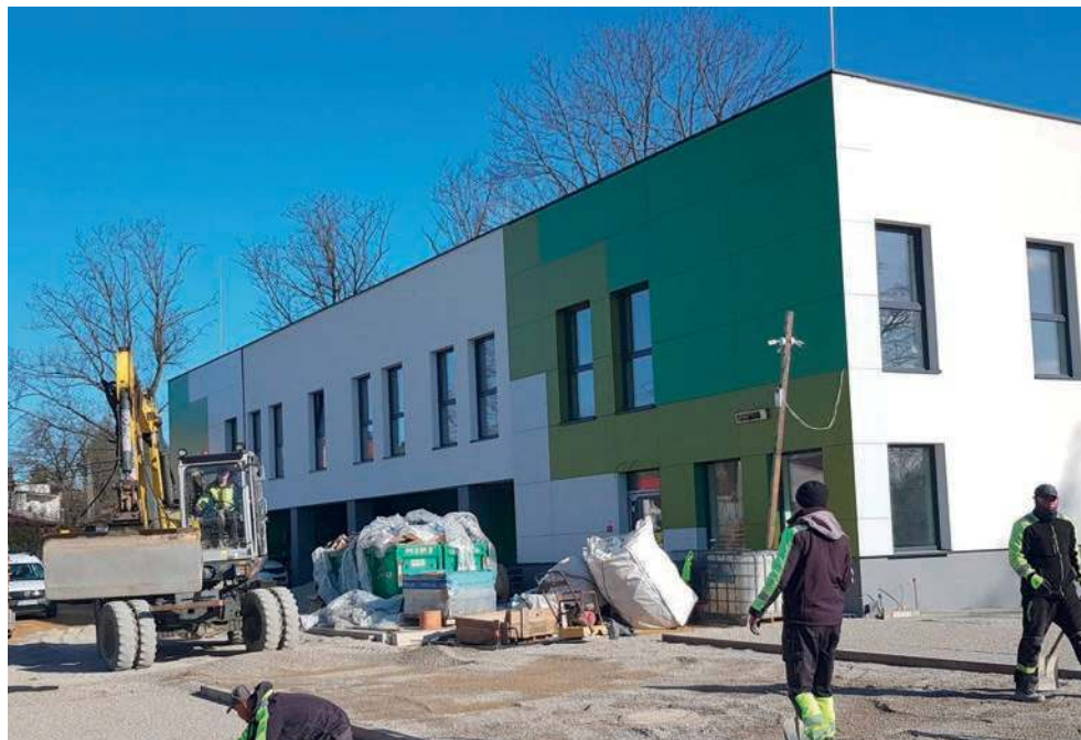
Trwają roboty na placu obok nowego budynku
