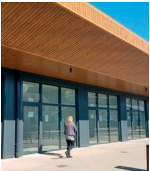
Dworzec autobusowy w Trzebinii
