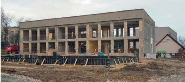
W budynku byłego przedszkola przy ulicy Wańkowicza trzeba będzie przeprowadzić dodatkowe prace
