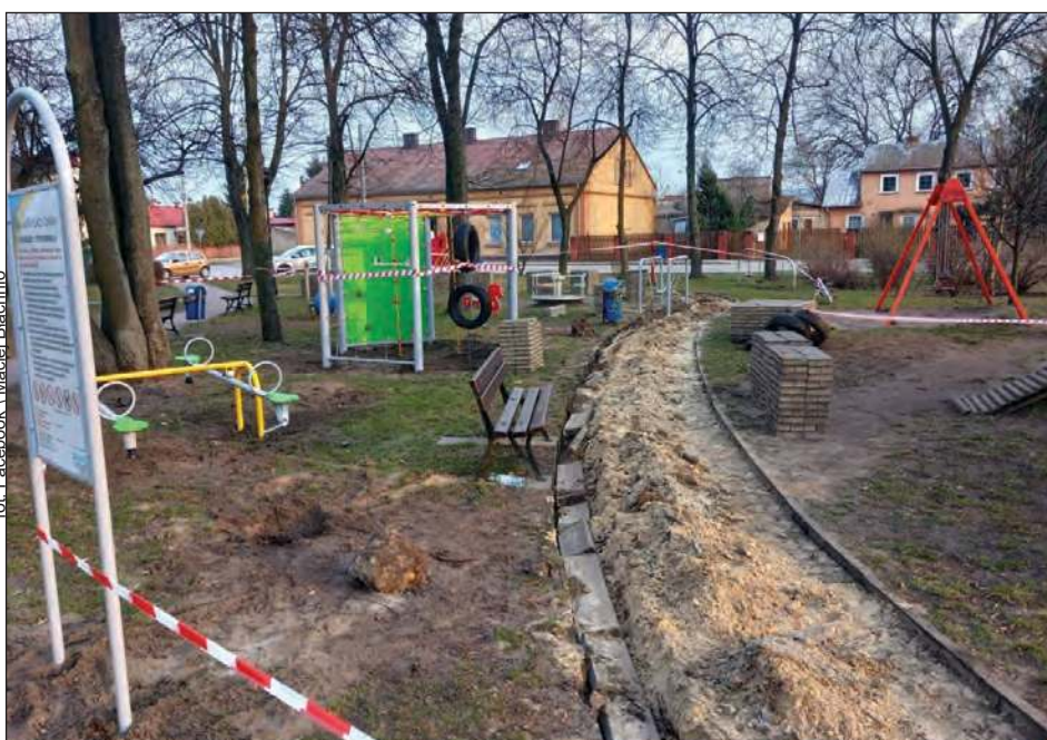
➤ Park przechodzi rewitalizację. Rozpoczęto od wymiany zabawek na placu zabaw. Kolejne kroki to wymiana kostki brukowej i budowa sceny
