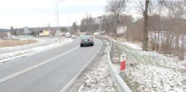
Poruszanie się ulicą Wojska Polskiego nie jest dla pieszych bezpieczne, nie ma tam chodnika po prawej stronie
