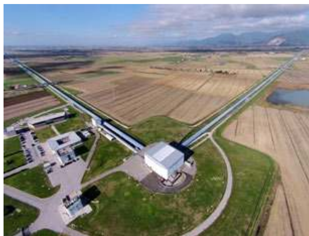
Fot. 2. Interferometr Virgo to wielkoskalowy instrument naukowy, znajdujący się w pobliżu Pizy we Włoszech, służący do wykrywania fal grawitacyjnych. https://en-wikipedia.org.translate.google/wiki/Virgo_interferometer?_x_tr_sl=en&_x_tr_tl=pl&_x_tr_hl=pl&_x_tr_pto=sc
