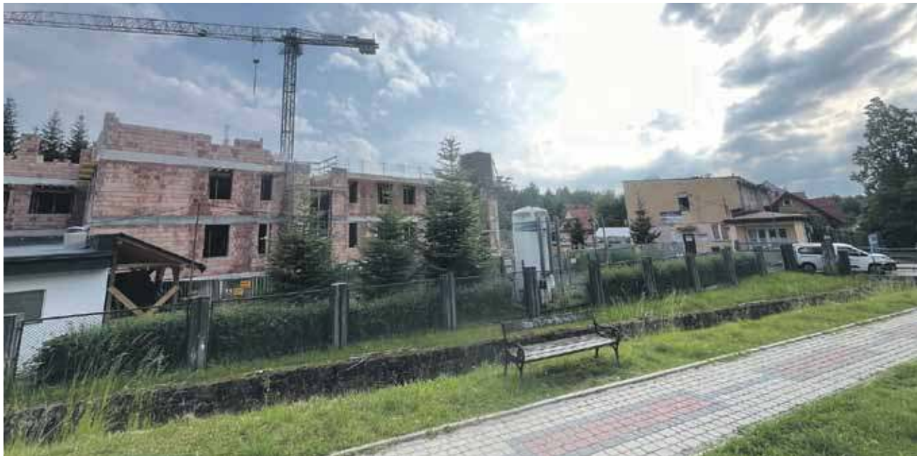
Szpital w budowie.
