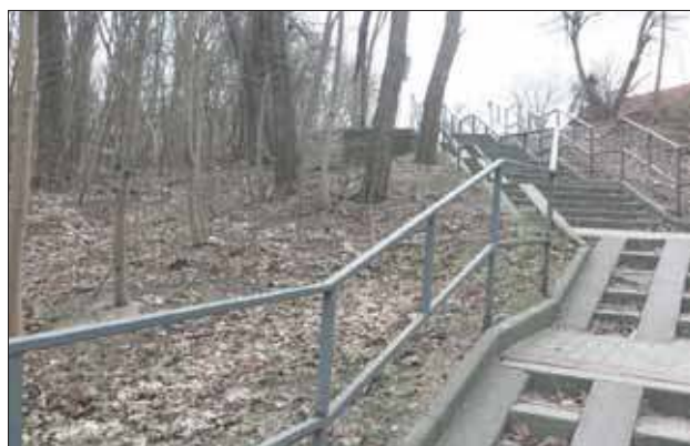
Miejsce jest niebezpieczne dla przechodniów
