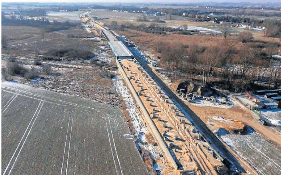
Najbardziej zaawansowane prace są przy budowie obwodnicy Mogilna
