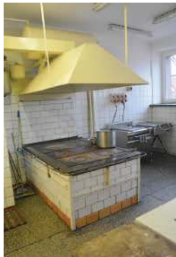
Stan przed modernizacją
