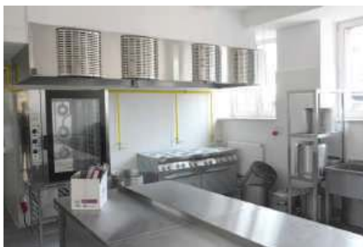
Stan po modernizacji
