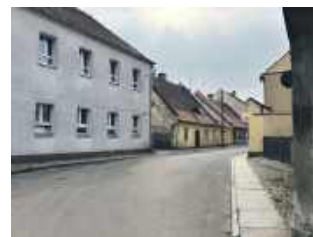
Prace prowadzone będą na ul. Czerwonego Krzyża
