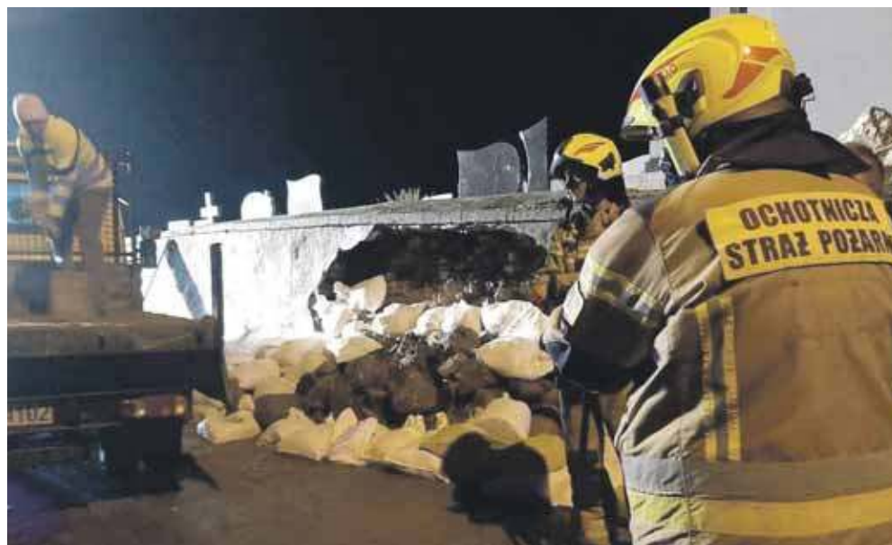
Strażacy zabezpieczyli mur workami z piaskiem
