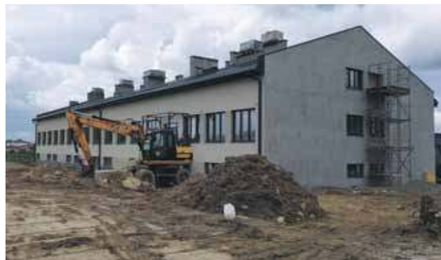
Przedszkole i żłobek jeszcze w budowie
