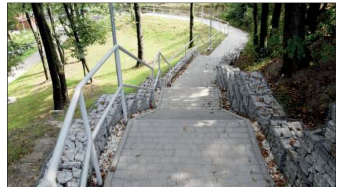
Przebiegający z Parku Aktywnej Rekreacji na I poziom platformy widokowej
