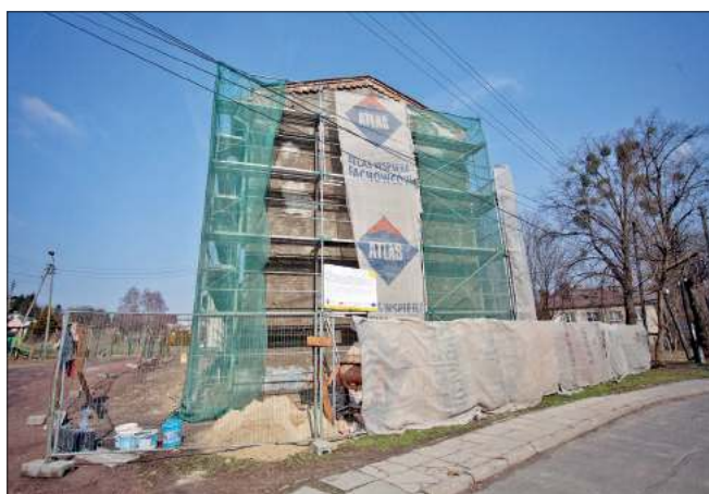
Przedmiotem inwestycji są m.in.: termomodernizacja, budowa instalacji gazowej oraz szeroko zakrojone roboty remontowe
