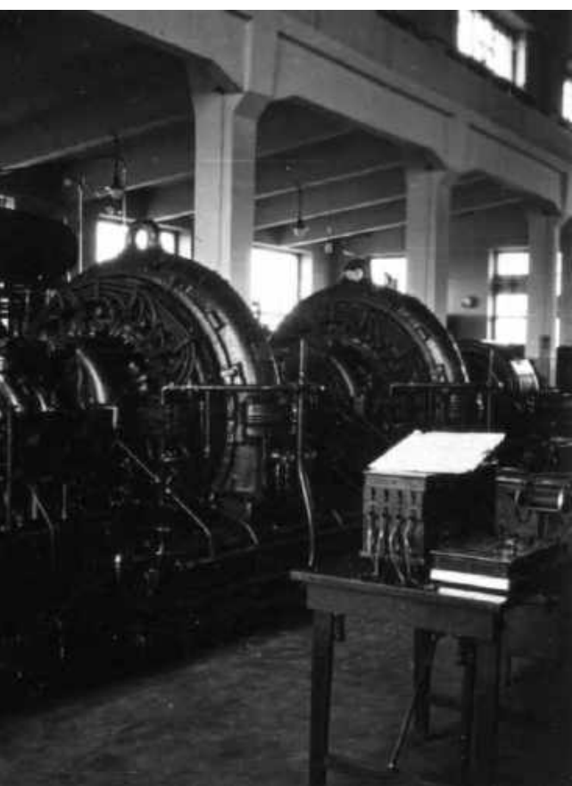
Nadajnik Centrali oparty na dwóch zestawach alternatorów Alexandersona
