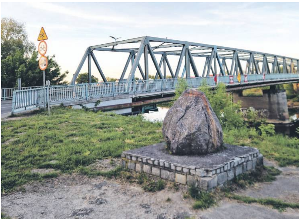
Tak to miejsce obecnie wygląda
