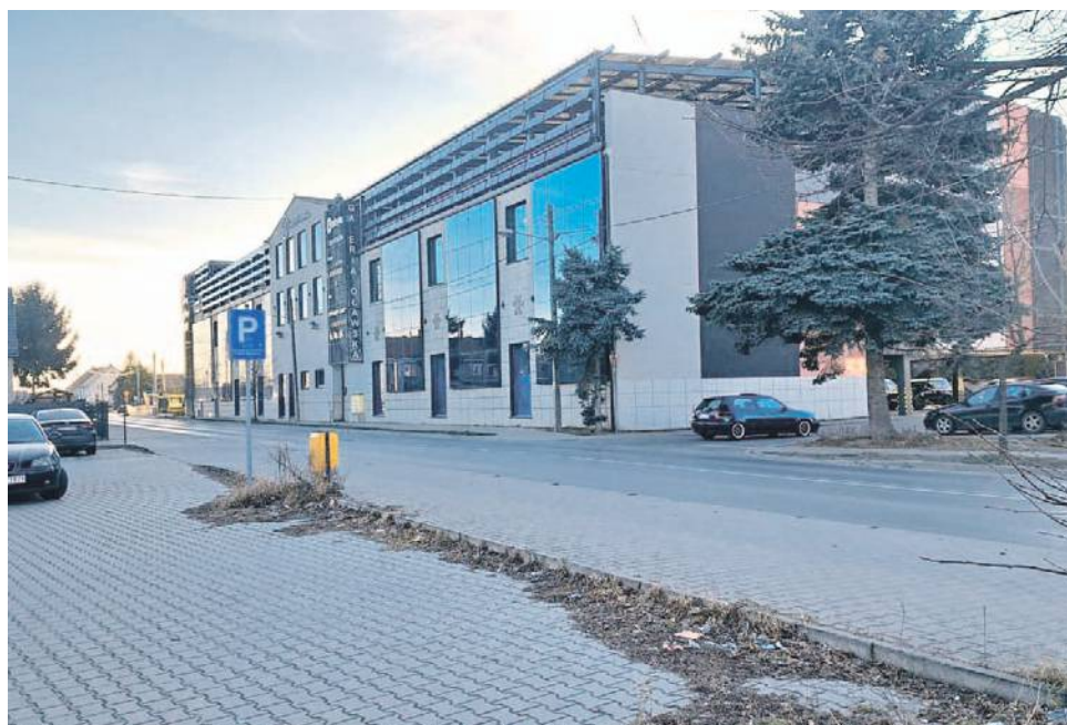
Tu będzie nowe przejście dla pieszych
