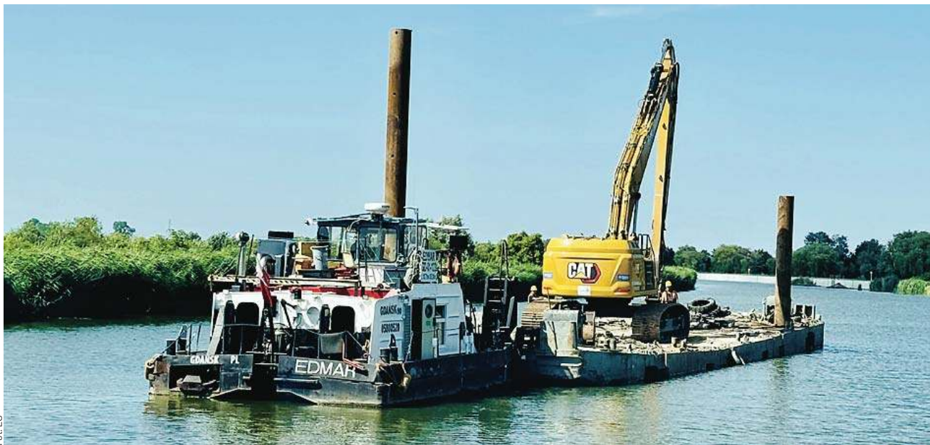
Prace pogłębiarskie na rzece Elbląg (czerwiec 2024 roku)
