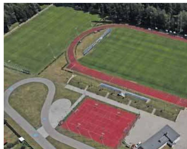
Zakres prac obejmuje szereg inwestycji, które mają zwiększyć funkcjonalność obiektu przy ul. Fabrycznej w Kaletach
