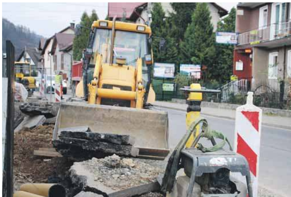
Nadal trwa układanie sieci gazowej przy ulicy Główniej w Szczawnicy.
