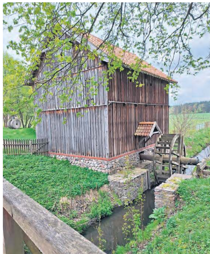
Muzeum Budownictwa Ludowego – Parku Etnograficznego w Olsztynku zawiera około 80 obiektów budownictwa ludowego z terenów dawnych Prus Wschodnich.
