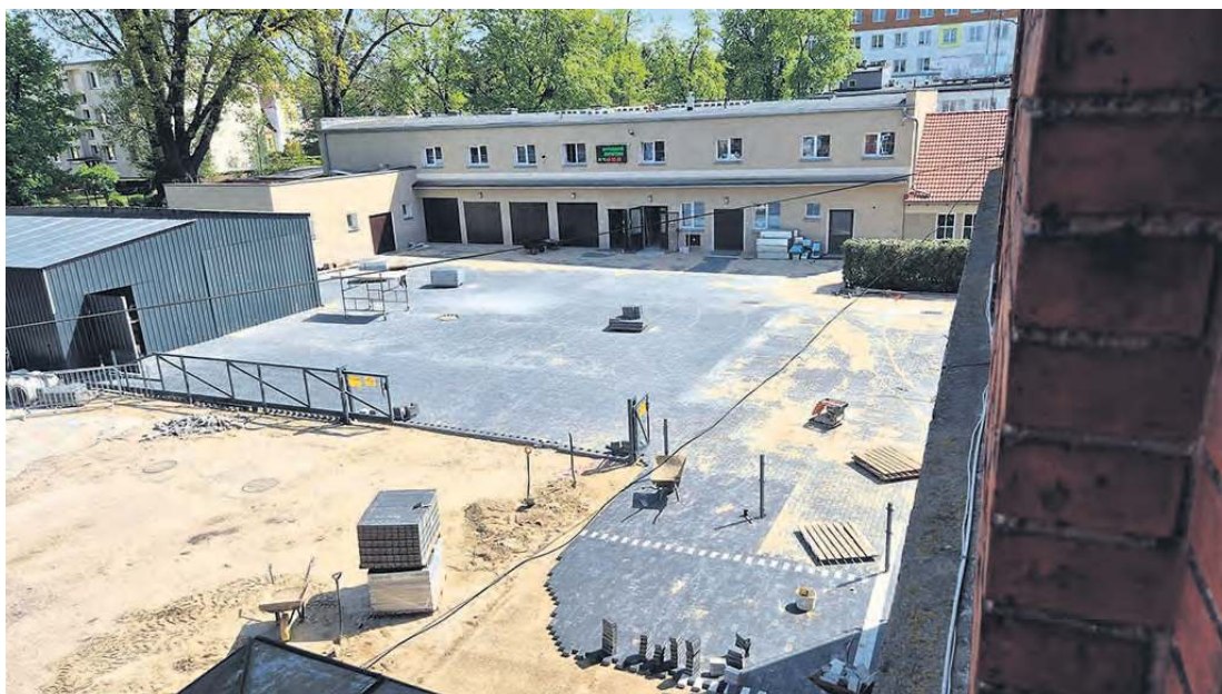
Plac na tyłach technikum został zmodernizowany. Fot. FB Brzozowe Centrum Umiejętności – Leśnictwo w Tucholi
