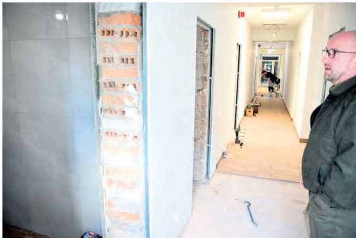
Jeszcze w kwietniu odwiedziliśmy plac budowy. Prace przez ten czas nieustannie postępowały. To parter internatu technikum, z wejściem od ul. Pocztowej. W tym miejscu będzie główna lokalizacja Branżowego Centrum Umiejętności w dziedzinie leśnictwa.
