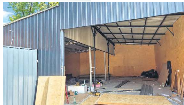
W ramach projektu modernizowane jest pomieszczenie warsztatowe i wiata. Fot. FB Brzozowe Centrum Umiejętności – Leśnictwo w Tucholi
