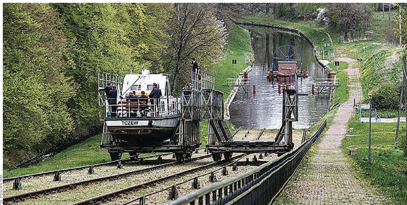
Jednostka pływająca pokonuje różnicę poziomów na specjalnym wózku po torowisku
