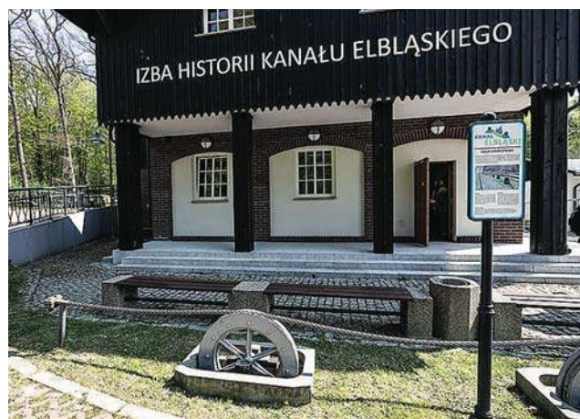
Budynek Izby Historii Kanału Elbląskiego w Buczyńcu
