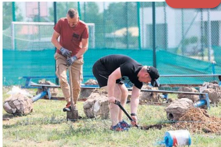
W budowie jest sektor dla gości – tzw. klatka.
