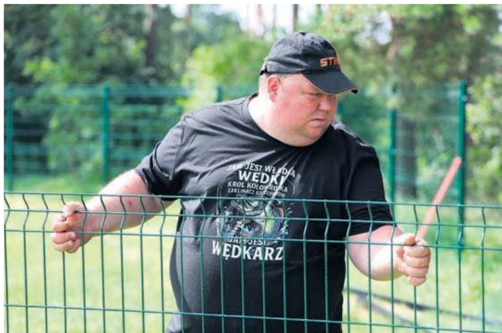
Dostawiane części ogrodzenia okalają już cały stadion.
