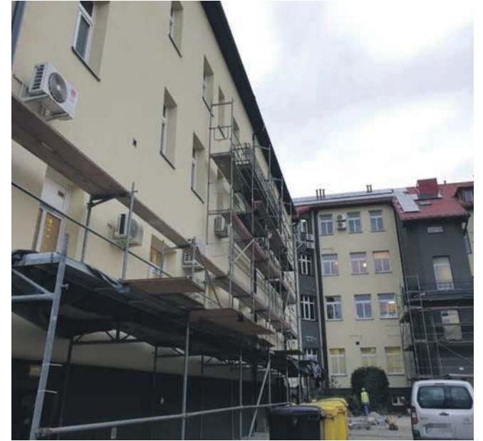
Tył przychodni ZLA w Chrzanowie przy ul. Sokoła jest ocieplany
