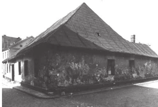
Chata gwarecka przy ul. Gliwickiej 23 została wyburzona
