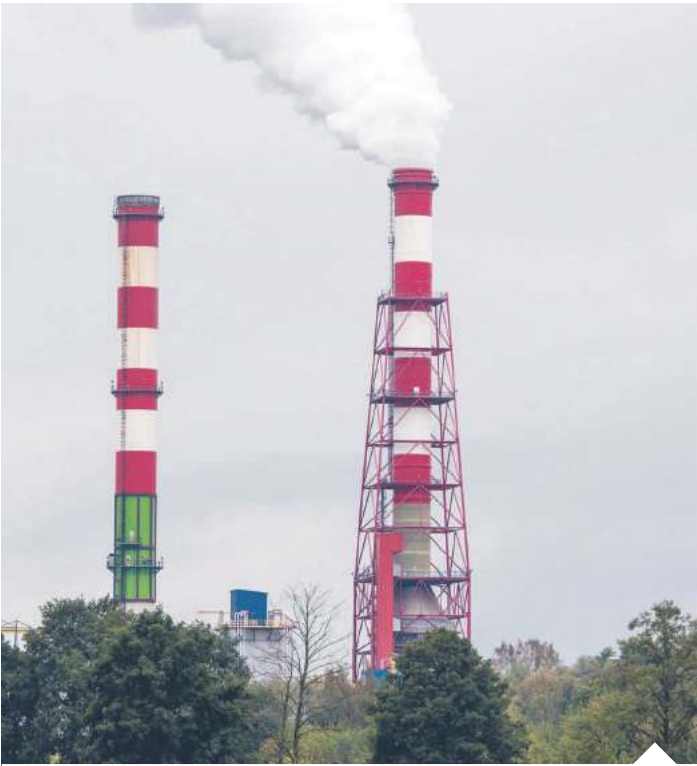
Blok C w Elektrowni Ostrołęka o mocy 1000 MWe będzie ostatnią inwestycją w nowe moce węglowe w Polsce | fot. Filip Błażejowski/Gazeta Polska
