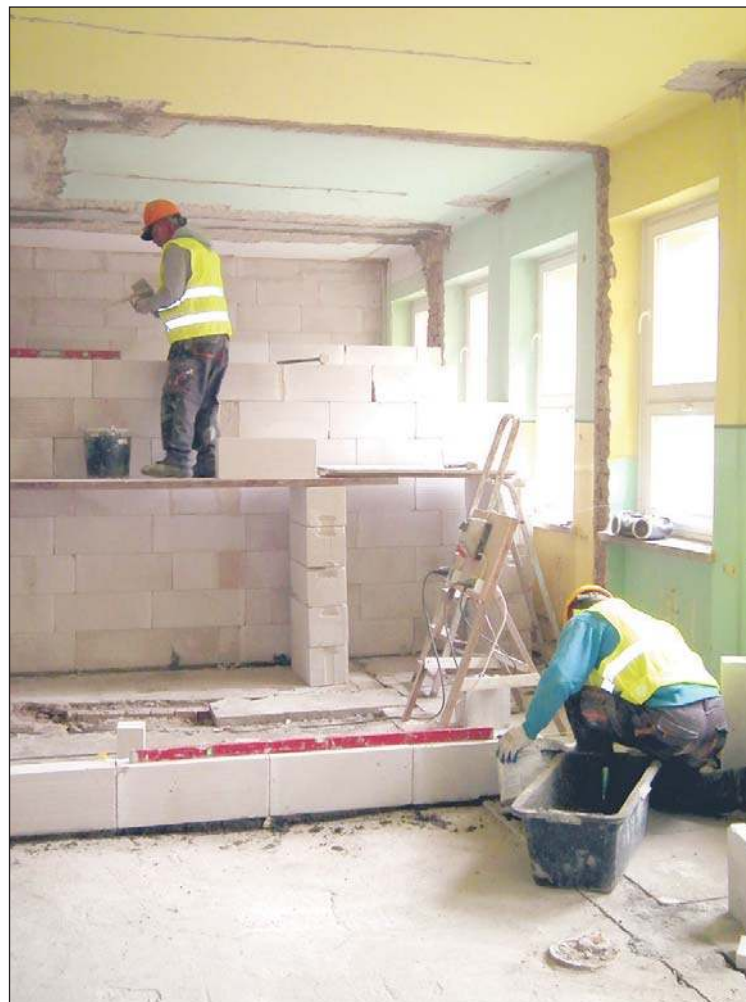
W Pustkowie Osiedlu przebudowa idzie pełną parą. Nowe ściany już stoją.
