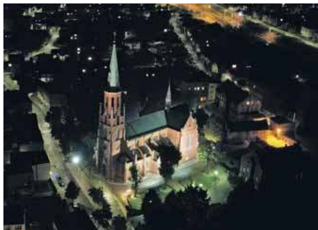
Wieża kościoła ma 61 m i 42 cm wysokości
