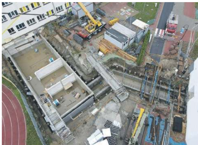
Zalany teren budowy łącznika przy Szkole Podstawowej nr 2 w Trzebnicy
