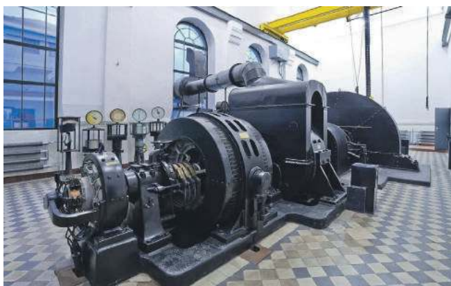
Napęd maszyny wyciągowej w Starej Kopalni.
