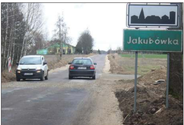
Droga prowadząca przez Jakubówkę zostanie poszerzona. Już teraz widać utwardzone tłuczniem pobocza, które niebawem zostaną pokryte asfaltem
