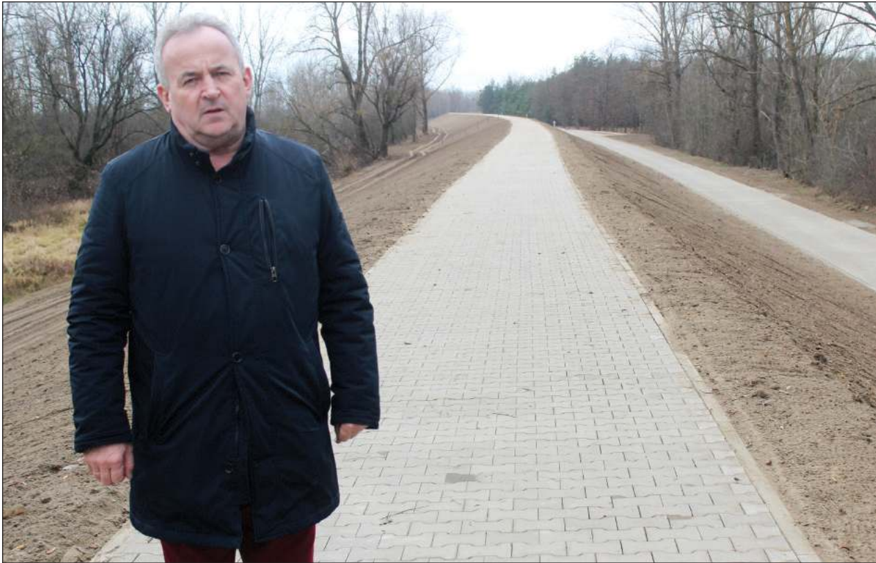
✚ - Jeśli wszystko dobrze się ułoży już niebawem Wody Polskie wyremontują kolejne 3 kilometry wału przeciwpowodziowego - mówi wójt Zbigniew Chłasiać
