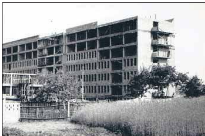
Budowa szpitala przy ul. Chełmońskiego
