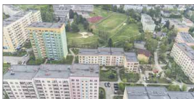
Spółdzielnia sprawdzi m.in. dachy i kominy
