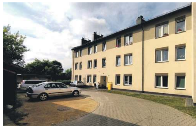
...i przy budynku 6a przy Szpitalnej, w rejonie skrzyżowania z ul. Podwale
