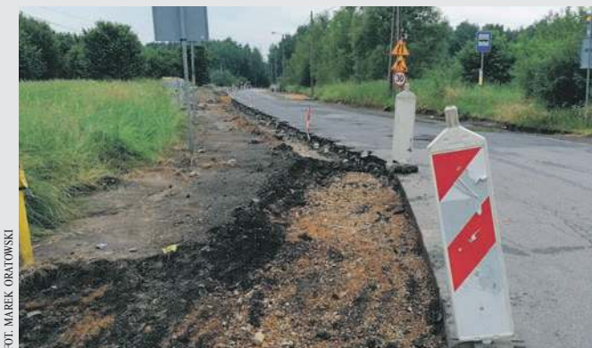
Trwa budowa drogi rowerowej na Powstańców Styczniowych w Chrzanowie
