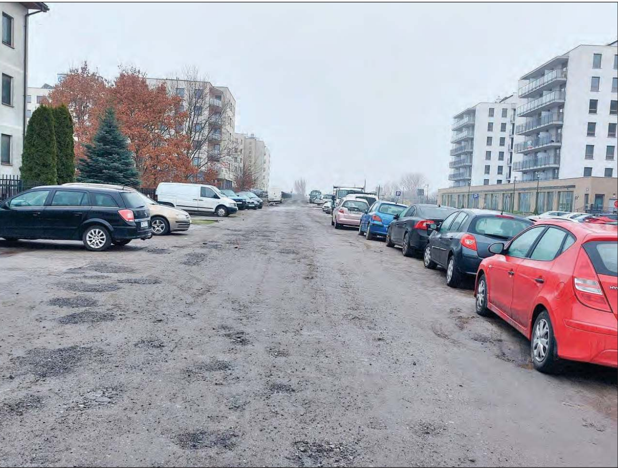
» -Nie dość, że nawierzchnia jest zniszczona, to jeździ ciężki sprzęt, a ulica jest zastawiona samochodami mieszkańców osiedla pana Ochnika -zauważa mieszkanka
