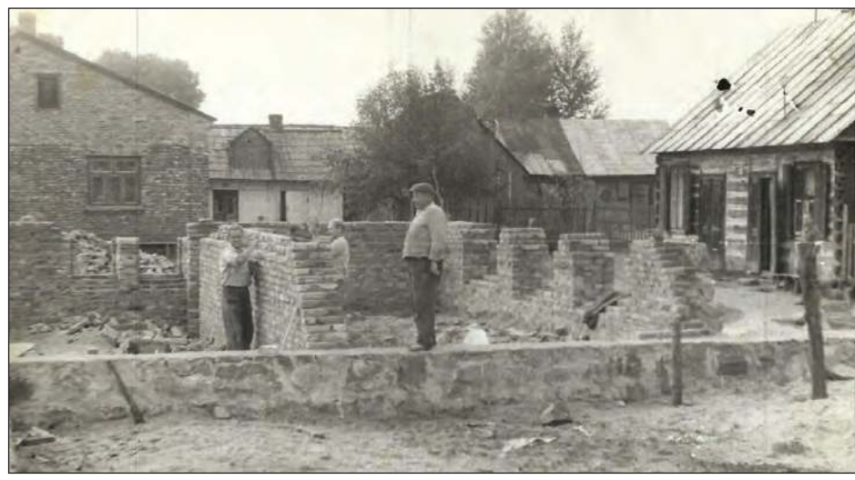
■ Budowa Domu Strażaka na ulicy Alejowej w Łaskarzewie. Lata 60. XX wieku. W środku stoi Leon Jabłoński , który nadzorował budowę (Zdjęcia ze zbiorów Stanisława Wójcika z Łaskarzewa. Serdecznie dziękujemy)
