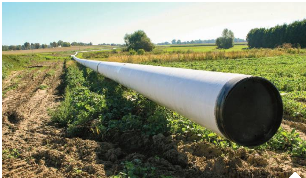
Realizacja drugiej nitki Rurociągu Pomorskiego, podobnie jak innych strategicznych inwestycji, została wstrzymana
