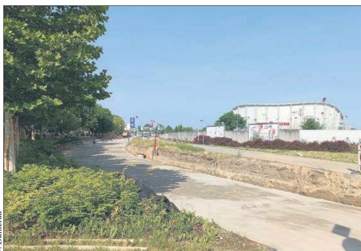
Trwa przebudowa ulicy Batalionów Chłopskich
