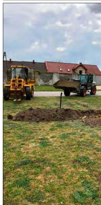
Podczas prac użyto ciężkiego sprzętu.
