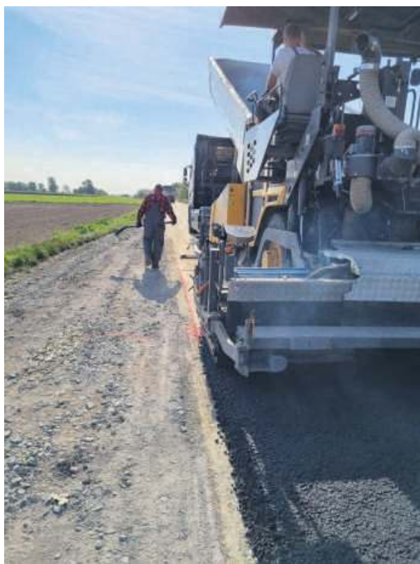
W ubiegły czwartek, 8 września, na drodze na zbiornik wodny w Kalinowej została położona warstwa wiążąca asfaltu. Fot. UMiG Wiązów
