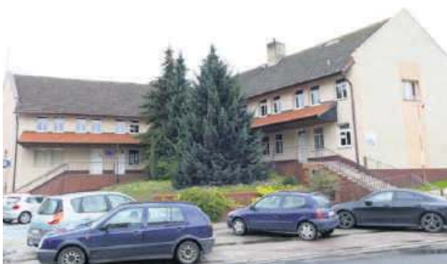
Radni zdecydowali o przekazaniu 405 tys. zł na remont dachu oraz modernizację pomieszczeń lekarskich i sanitariatów w Ośrodku Zdrowia w Przewornie
