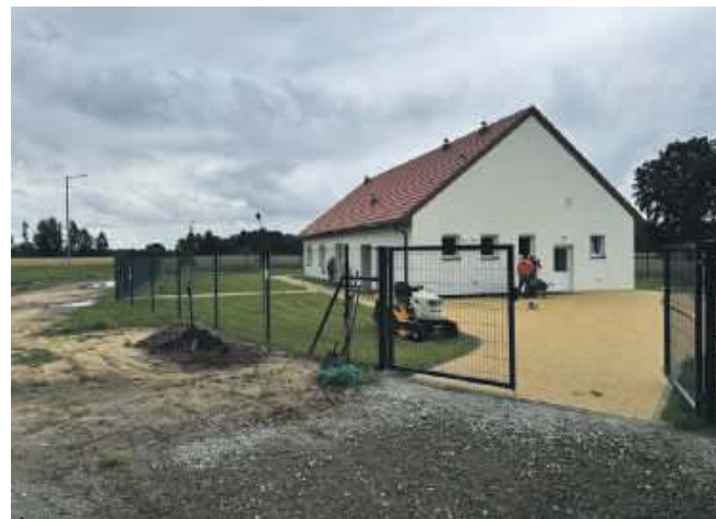
Świetlica w Brzeziu już na ukończeniu, ale dojazd jest po starej drodze
