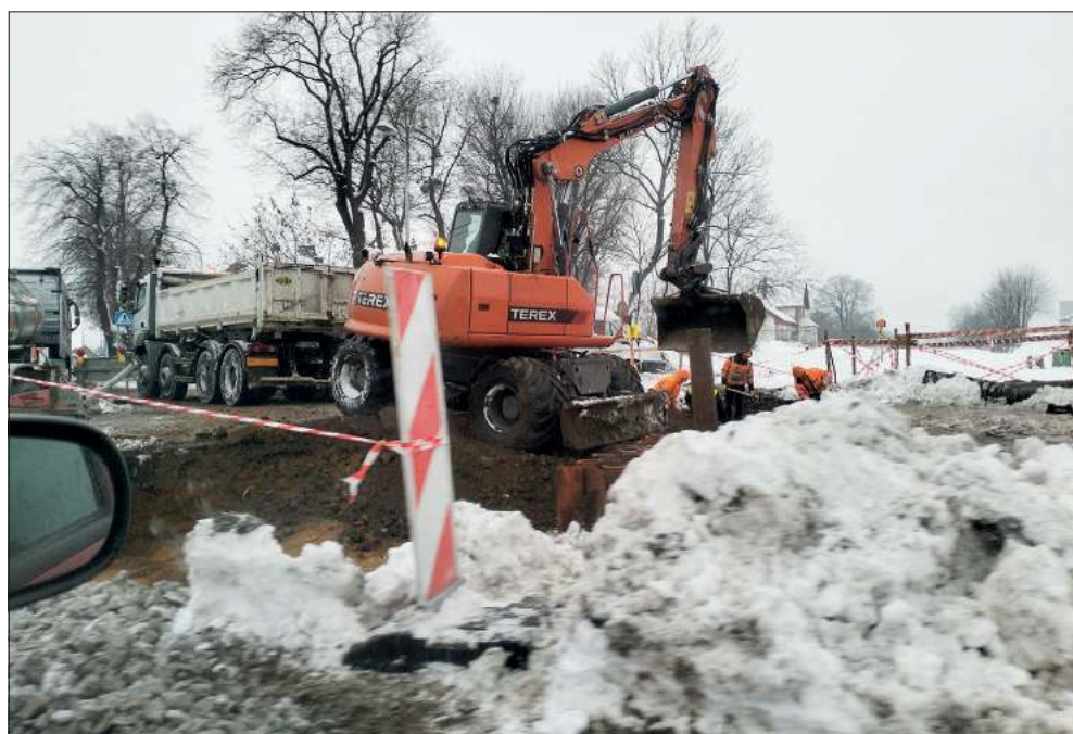
■ Remont przejazdu kolejowego w Studziennej
