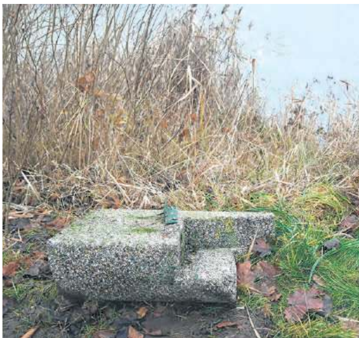
Zniszczenie tych elementów infrastruktury wymagało dużo siły i tyle samo głupoty.
