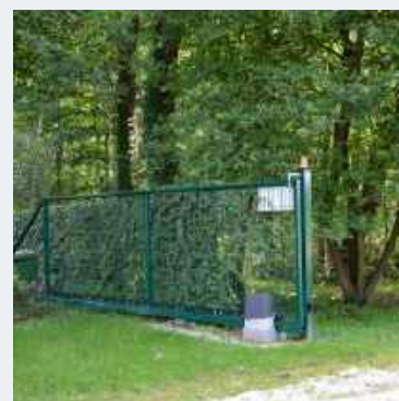
❷ Przęsła z drutu o grubości 5 mm (ocynkowanego i zabezpieczonego proszkowo) wytrzymują ciężar bluszczy.
