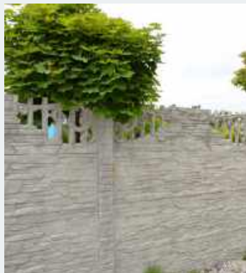
➤ Faktura paneli imituje łupany granit, ale została wytloczona w betonie.
