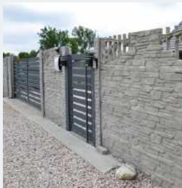
➤ Brama i furtka ze stali oraz ażurowe wstawki w panelach betonowych zmniejszają masywność ogrodzenia.
