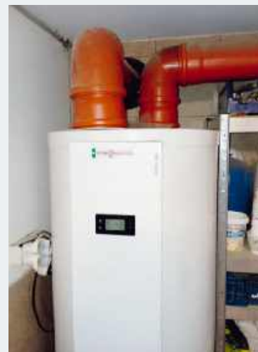
➤ Powietrzną pompę ciepła przeznaczone do przygotowywania c.w.u.
