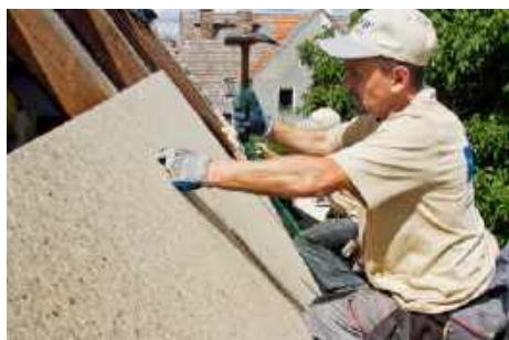
🔧 Sztynny podkład z drewnopochodnych płyt mfp układa się pod lekkie pokrycie z blachy płaskiej i pod gonty bitumiczne. WOODECO
