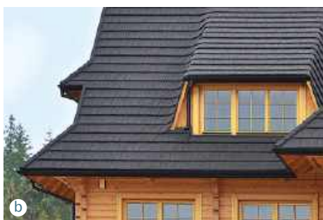
a Blachodachówka z powłoką poliestrową (a RUUKKI) i posypką mineralną przypominającą tłupek kamienny (b AHI ROOFING).
