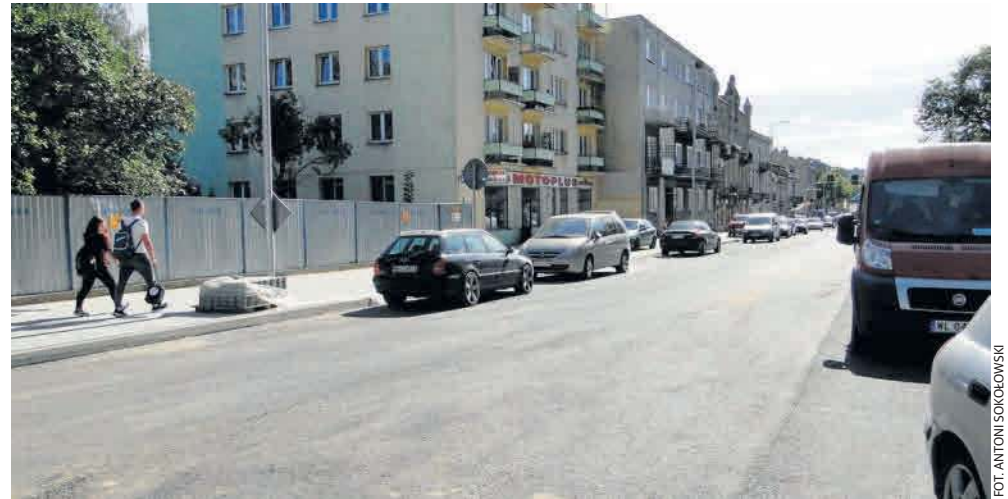
Na odnowionym fragmencie ulicy 25 Czerwca zostały ułożone chodniki, ustawiono nowe latarnie.
