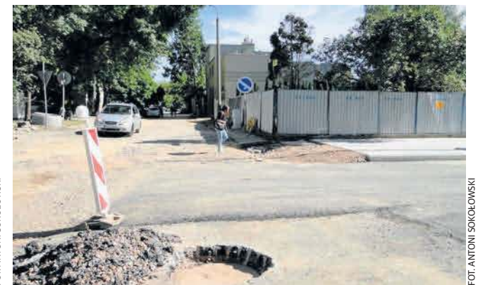
Po zakończeniu wykopów wjazd i wyjazd z ulicy Zacisze do ulicy 25 Czerwca jest teraz ułatwiony.
