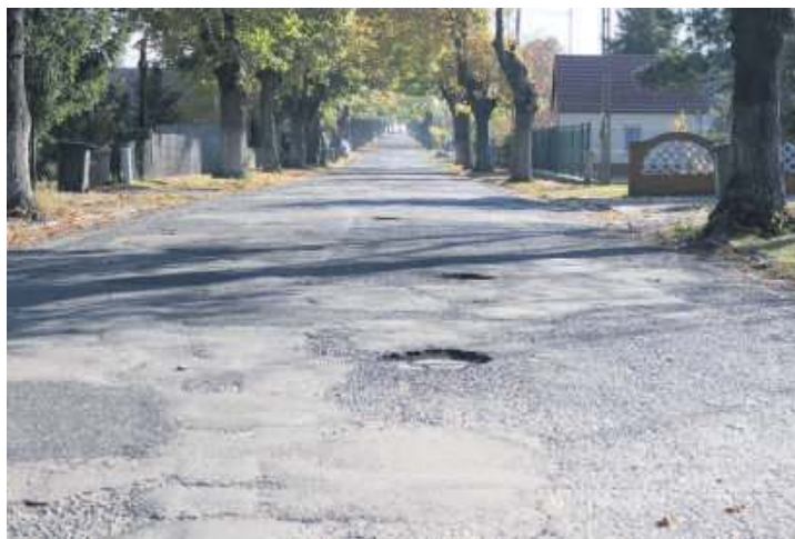
Koszt remontu drogi powiatowej w Starym Wiązowie to około 330 tysięcy złotych
