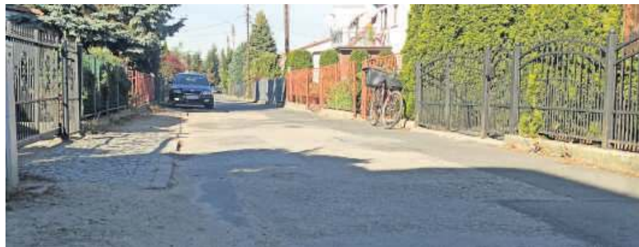
W ramach dofinansowania na ulicy Żwirki i Wigury w Strzelinie przebudowana zostanie sieć wodno-kanalizacyjna, a także wykonana będzie nowa nawierzchnia bitumiczna jezdni
