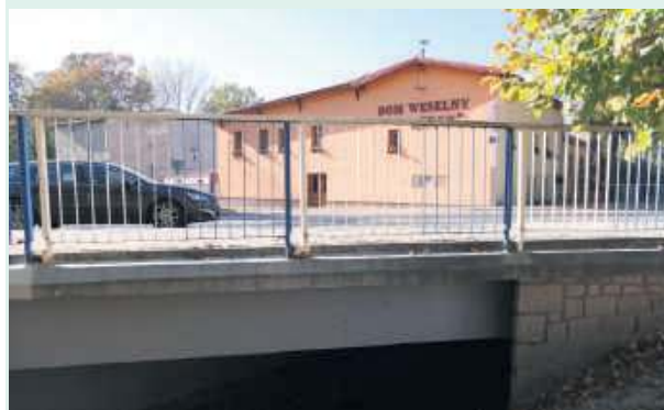
Zmiana organizacji ruchu na ulicy Wojska Polskiego w Strzelinie jest związana z trwającym remontem mostu na Młynówce
