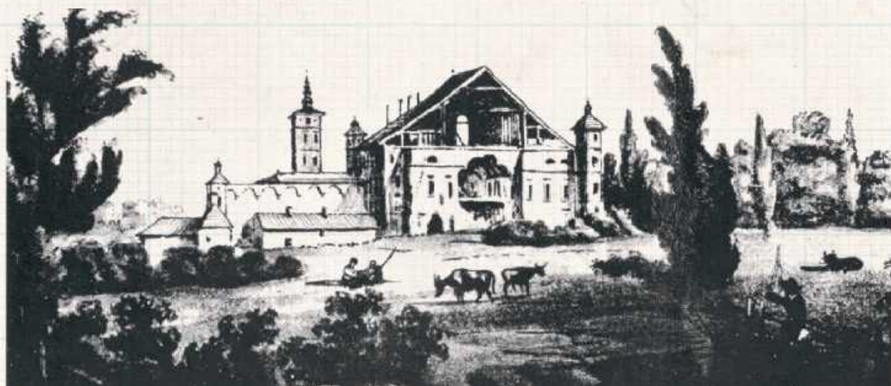
Nieznanego autorstwa grafika z około 1852 przedstawiająca Pałac. Widzimy go od strony Krzny już w stanie daleko posuniętej degradacji, z uszkodzonymi murami i dachem. Vineberg oglądał go siedemdziesiąt lat później, kiedy - podobnie jak obecnie - dominującym elementem krajobrazu była już tylko wieża nad bramą
