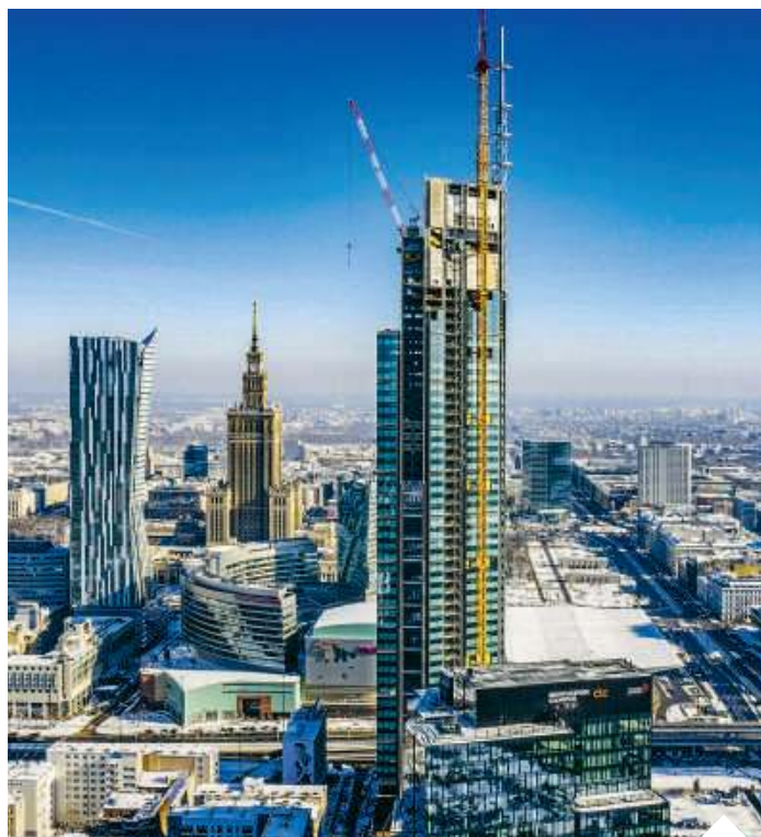
Powstający Varso Tower będzie najwyższym biurowcem w Unii Europejskiej
