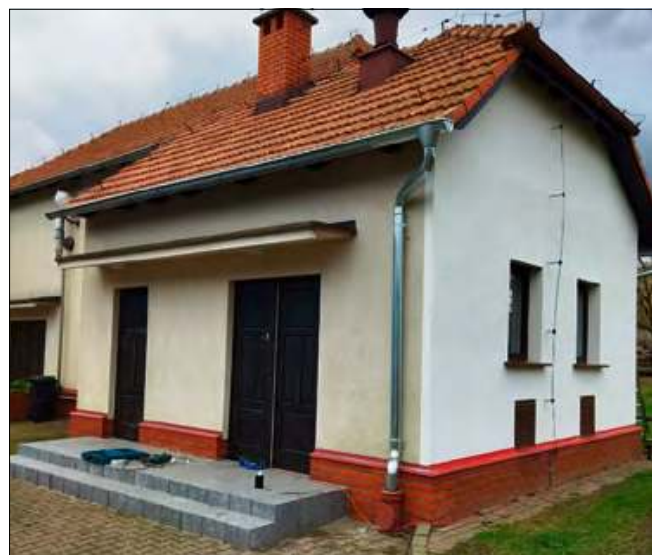
Rynny zamontowano na budynku stacji uzdatniania wody.
