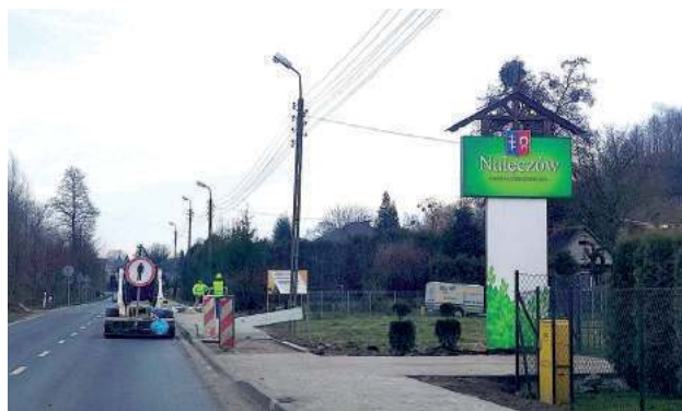
Na terenie gminy Nałęczów prace zakończyć mają się jeszcze w tym roku
