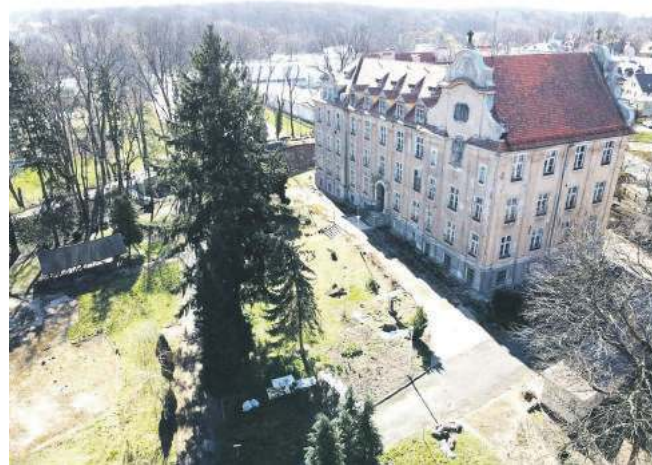
Nie widać szans na zagospodarowanie budynku
