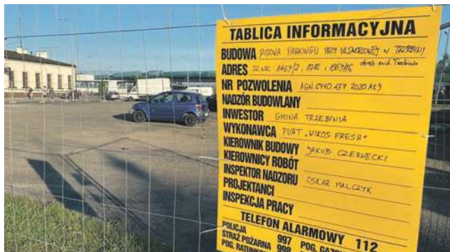
Prace rozpoczęto od ogrodzenia terenu budowy
