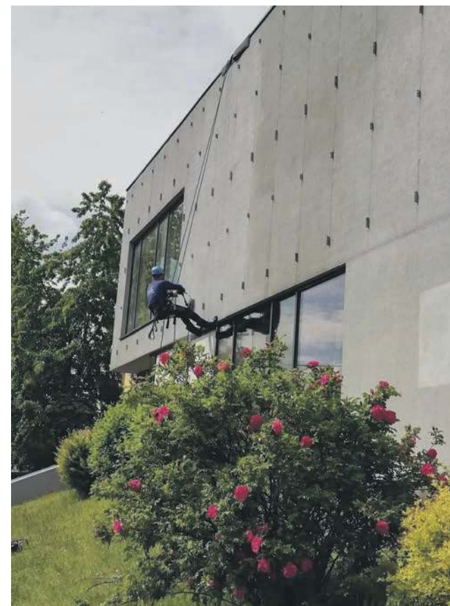
Wykonywane przez Silver-Service roboty wysokościowe
