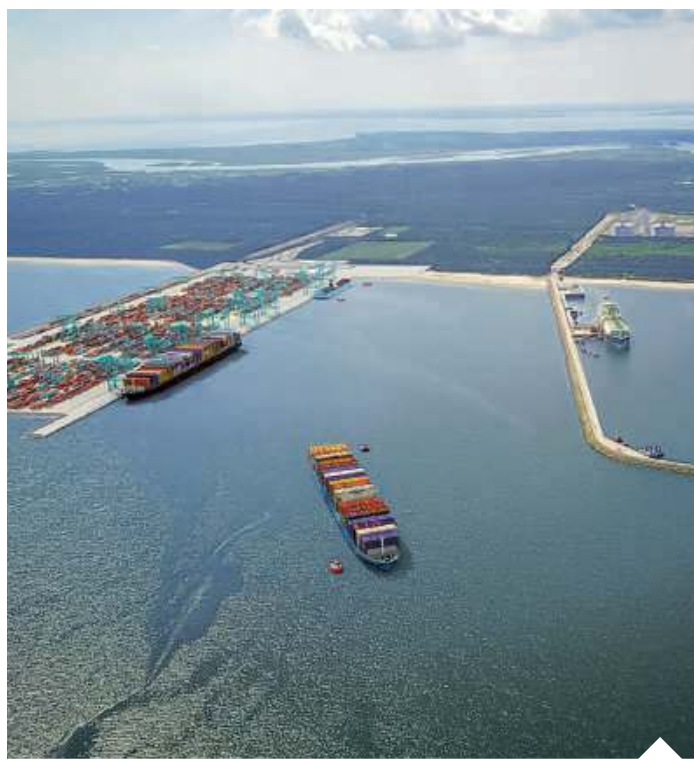
Kontenerowy port w Świnoujściu będzie spełniać najwyższe standardy bezpieczeństwa i ochrony środowiska | fot. mat. pras./d
